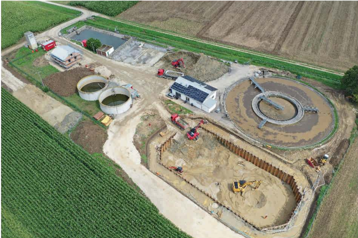
Bild links oben: Neubau Betriebsgebäude
