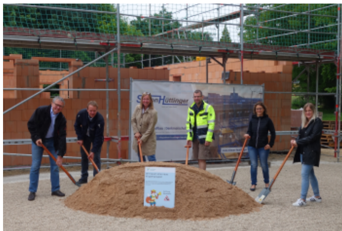
Spatenstich zur Krippenerweiterung in Wettelsheim mit Anbau im Hintergrund
