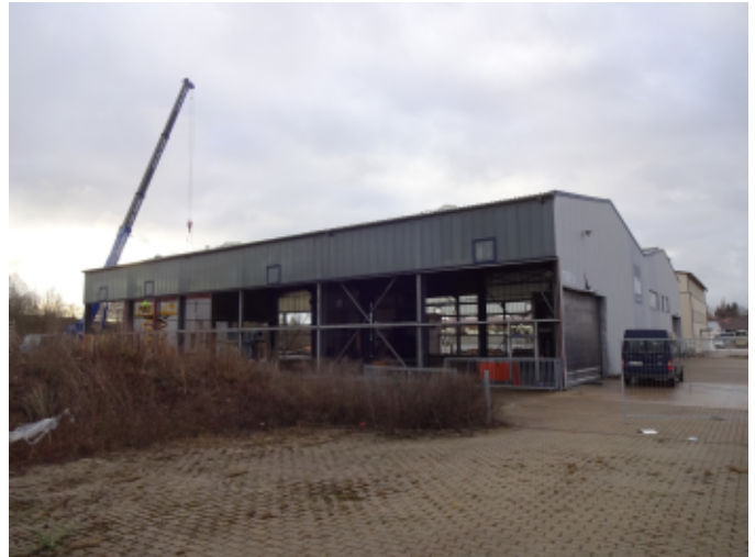
Abbruch der ehemaligen KB-Halle, auf deren Areal das Feuerwehrhaus entsteht.
