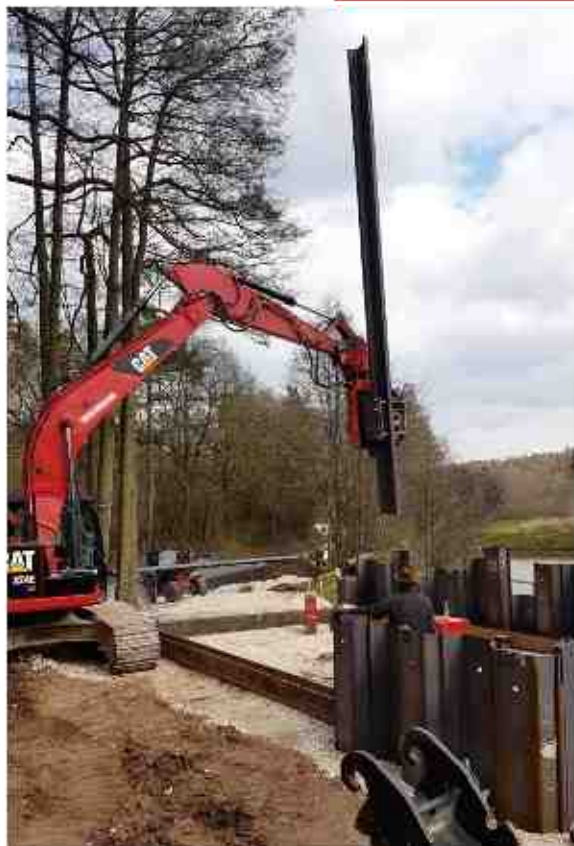
Herstellen des Baugrubenverbau mittels Spundbohlen Larssen 603 Bohlenlänge 10,0 m
