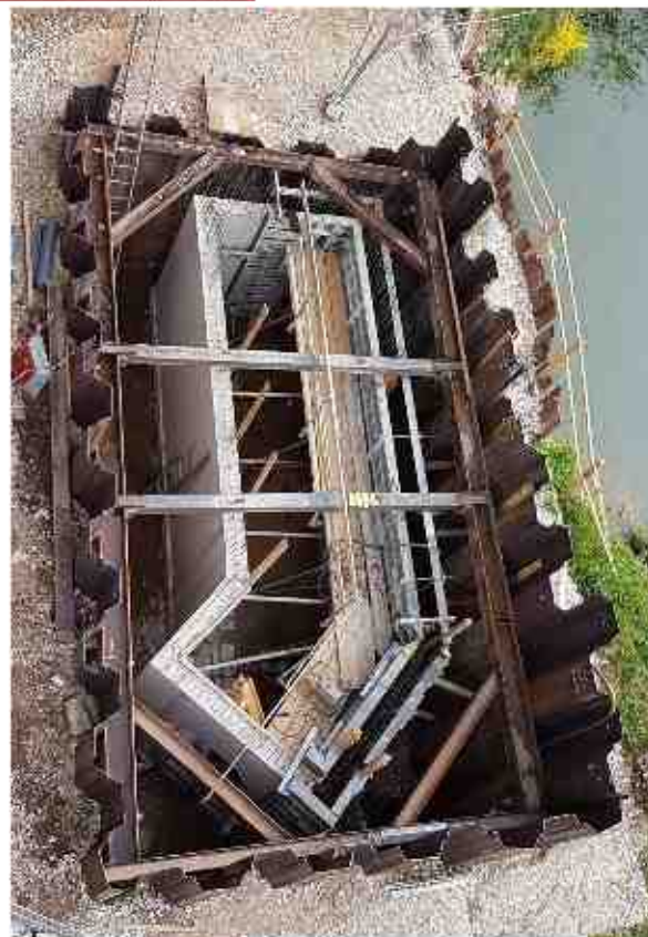
Luftaufnahme fertiggestellter Spundwandverbau inklusive Aussteifungsrahmen – Drosselbauwerk im Bau Linke Seite: betoniert - rechte Seite: Schalung zugestellt
